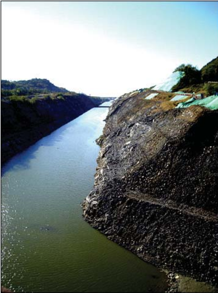
〈사진 1〉 운하굴착 전경
